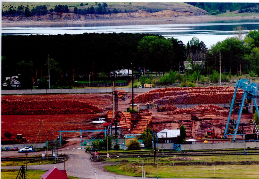
Железнодорожная станция Макарьево
